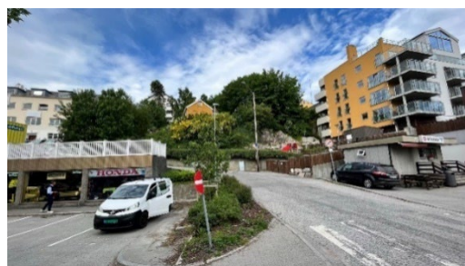
Figur 38 Påhugsområde ved campus. Tunnelinnslag i skrenten bak "Stappebua"
